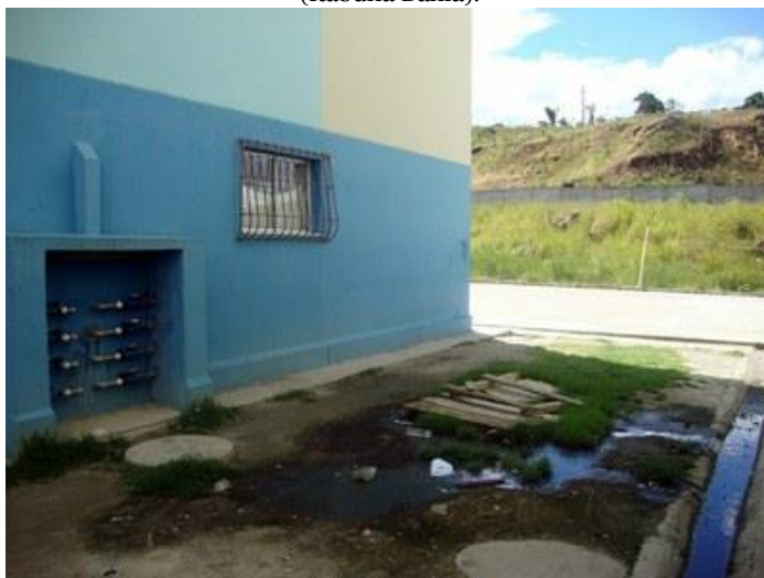
Figura 03 – Esgoto a céu aberto presente no Condomínio Pedro Fontes Araújo (Itabuna Bahia).
